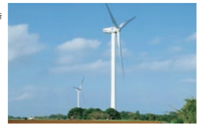
発電事業を行う 銚子しおさい風力発電所
