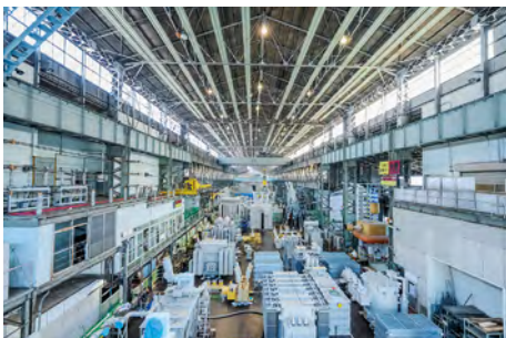
沼津事業所 変圧器工場
