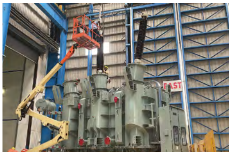
インド 変圧器組立ての様子
