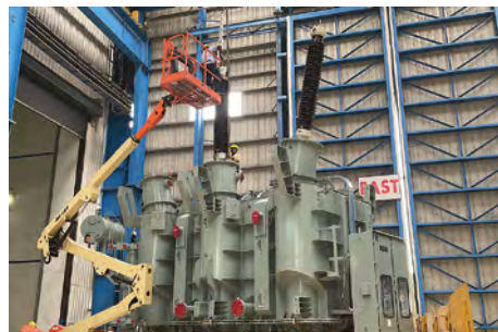
インド 変圧器組立ての様子
