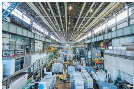
沼津事業所 変圧器工場
