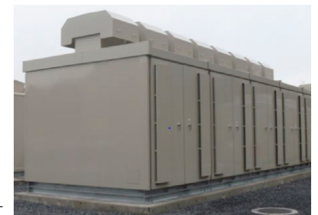
リチウムイオン電池用パワーコンディショナー
