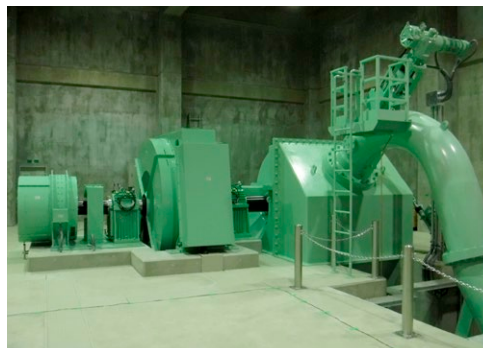
横軸二射ペルトン水車と横軸同期発電機
