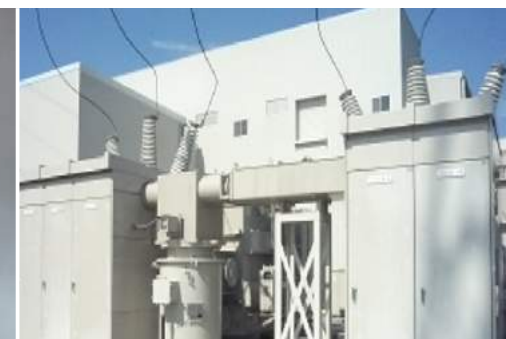
キュービクル型ガス開閉装置
