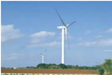
銚子しおさい風力発電所
