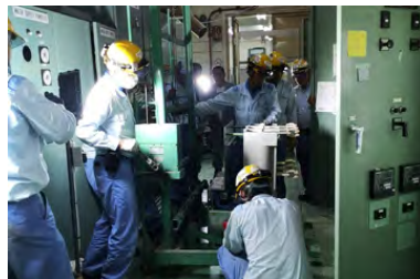
設備更新の様子
