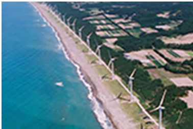
八竜風力発電所
