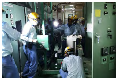
設備更新の様子
