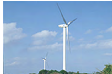
銚子しおさい風力発電所
