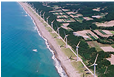
八竜風力発電所
