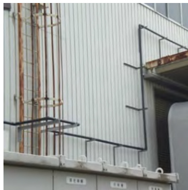
工場の工業用水配管を地上化
