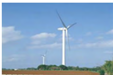
銚子しおさい風力発電所
