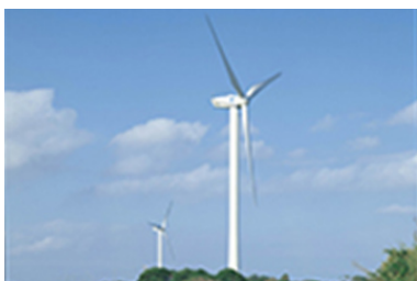
銚子しおさい風力発電所
