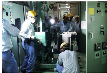
設備更新の様子
