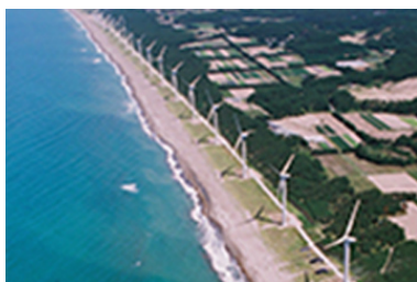
八竜風力発電所
