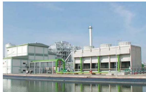
タイ向けバイオマス火力発電プラント
