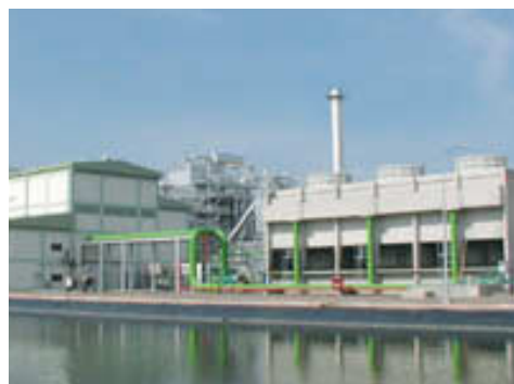
タイ向けバイオマス火力発電プラント
