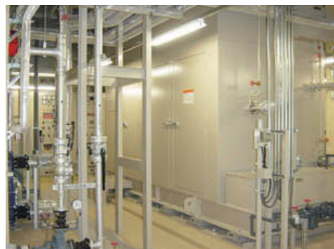
脱硝装置付きディーゼルエンジン コージェネレーションシステム
