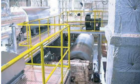
下水汚泥炭化システム
