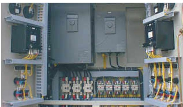
沼津事業所では、飲料水及び工業用水として井戸水を利用しております。この度、汲み上げ用ポンプ電動機のインバータ制御を行い、消費電力を約50%削減することが出来ました。この結果を踏まえ、汲み上げ量の多い他の井戸についてもインバータ化を進めています
