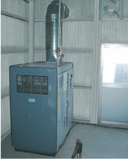
老朽化対策と省エネ対策のため、使用実績と電力計測を行い、インバータ化と定格の最適化(小形化)を進めています。また、排気の屋外放出と換気扇設置により設置環境整備を行い、省エネ対策を行っています。
