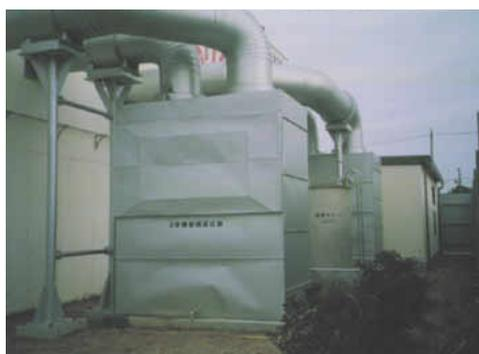
排ガス脱硝装置
