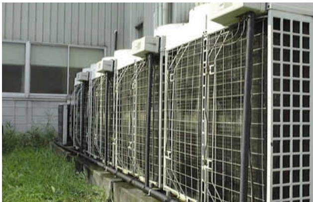
クーラー室外機に水を間欠噴霧し、気化熱を利用して冷却効率をアップさせ夏期の電力量削減に威力を発揮しています。
