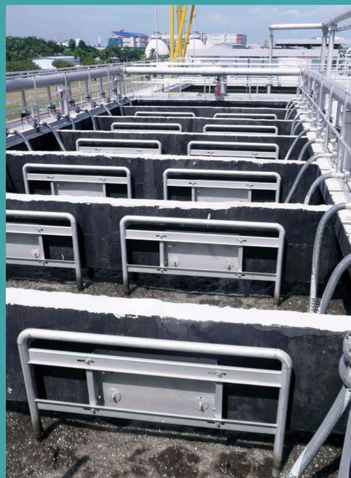
セラミック平膜によるろ過工程
