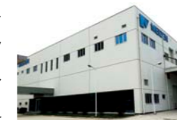
明電舎電気工程有限公司 (Meiden Zhengzhou Electric Co., Ltd.) GIS用アレスタ新工場
