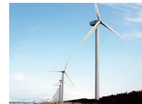
八竜風力発電所
