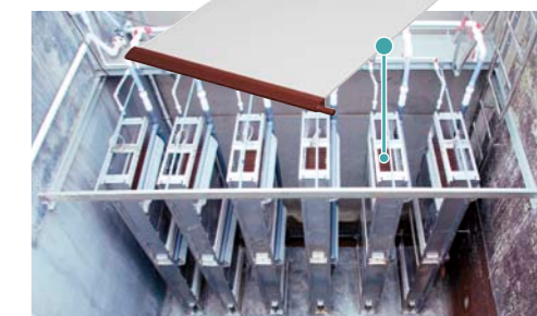
水処理プラントに設置されたセラミック平膜ユニット
