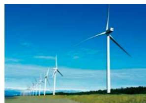
八竜風力発電所
