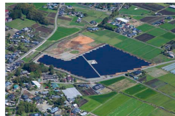
熊本一武ソーラー発電所
