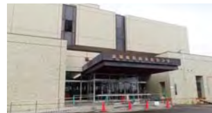
県南浄化センター
