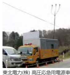
東北電力(株) 高圧応急用電源車
