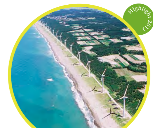
八電風力発電所
