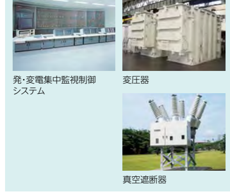
発・変電集中監視制御システム 変圧器 真空遮断器
