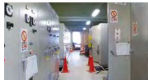
沈砂池ポンプ棟 電気室
