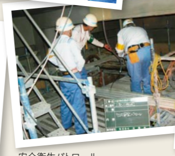
安全衛生パトロール
