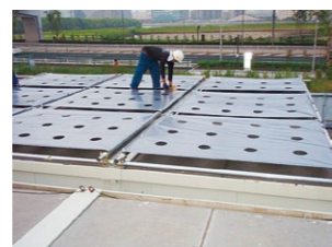
遮熱シート施工例
