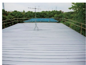
遮熱塗料施工例
