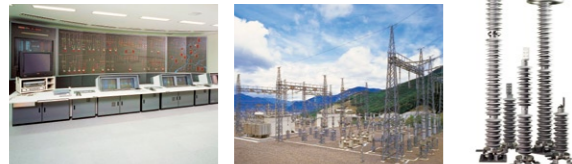
発・変電集中監視制御システム
