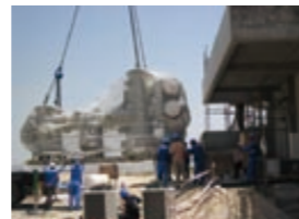
132kV ガス絶縁開閉装置 (GIS) 搬入
