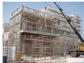
132kV 受変電所外観
