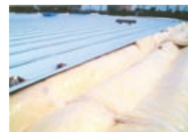
二重化屋根工事
