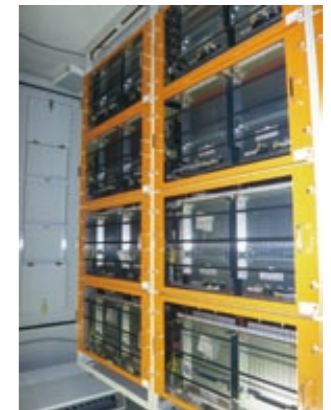
内部の電気二重層キャパシタ
