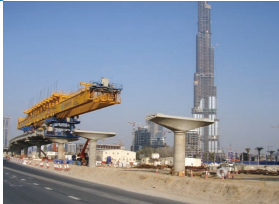
建設が進むドバイ LRT (新交通システム) 工事
