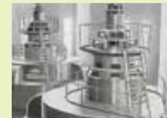
2000HP72極圧延機用誘導電動機(日本製鐵金石製鐵所)
