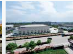
明電舎(杭州)電気システム有限公司 (中国)
